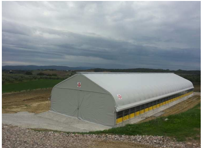
Metallstruktur, feuerverzinkt nach Verarbeitung, PVC Plane, Breite von 6.1 bis 14 M und Höhe bis 6.80 M (Modell Tunnel Ovile)
