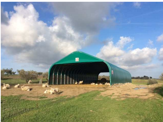
Metallstruktur, feuerverzinkt nach Verarbeitung, PVC Plane, Breite von 6.1 bis 14 M und Höhe bis 6.80 M (Modell Tunnel Ovile)
